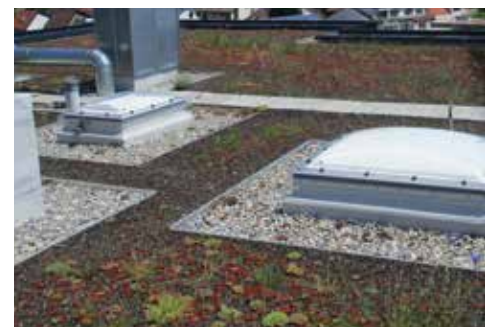
Kurz nach der Aussaat grau, dann saisonal rot und nun immer üppiger und grüner: die extensive Dachbegrünung
